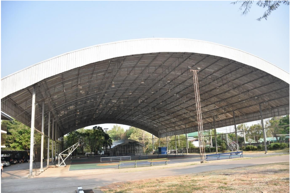
อาคารอเนกประสงค์โดม
